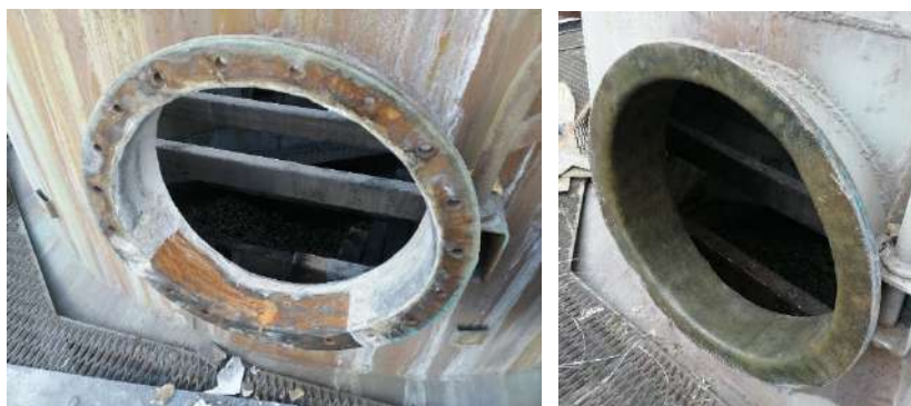
Рисунок 3. Локальный ремонт с применением ПКМ (до и после ремонта).
