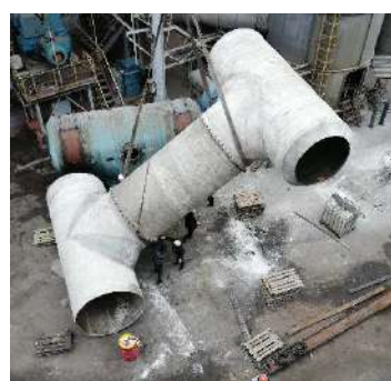
Рисунок 2. Монтаж элемента газохода.
